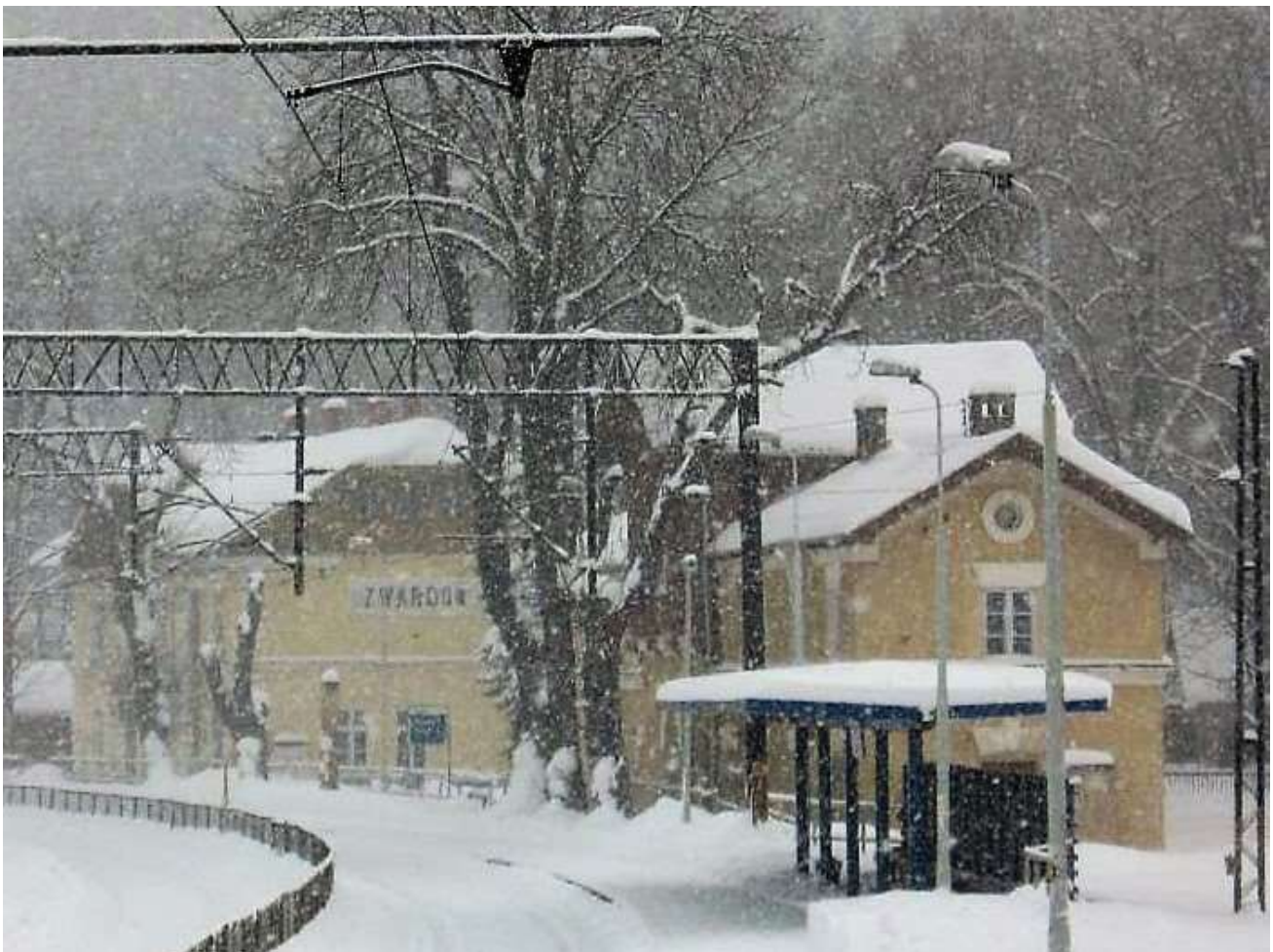
Železničná stanica Zwardoń s pôvodnými budovami.
